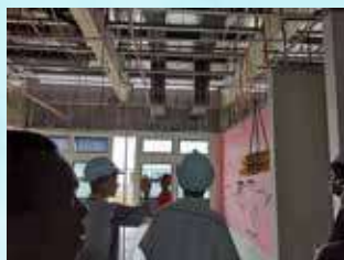
正在视察施工中的医院工地。
